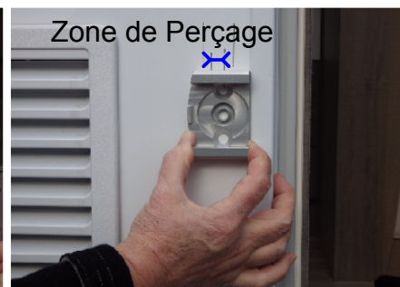
7 - Ici Fixation Directement sur le Panneau
