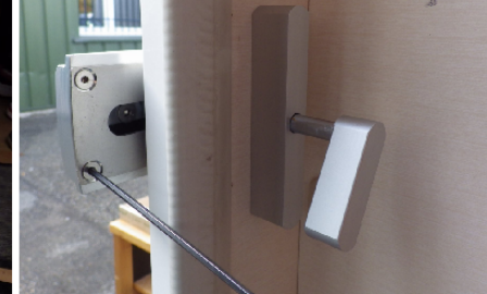
17 - Montez & Bloquez la Manette (Fermé en Bas) puis Enfilez la Tole Inox & monter les 2 Vis FHC-M4
