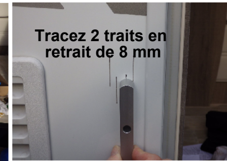
5 - et Déterminez la zone de perçage
