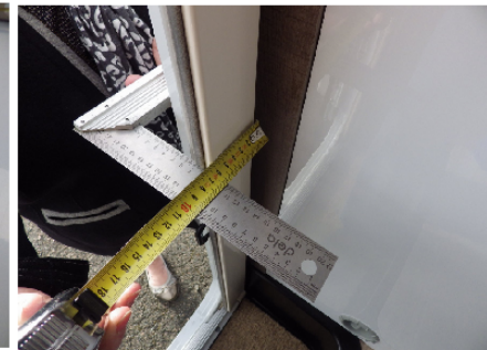
3 - Mesure de la Cote Mini - Ici 62
