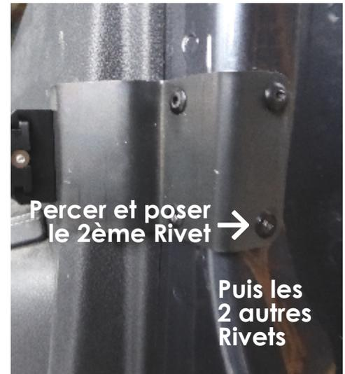
Percer et poser le 2ème Rivet
