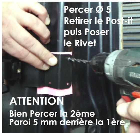
Percer Ø 5 Retirer le Post-it puis Poser le Rivet
